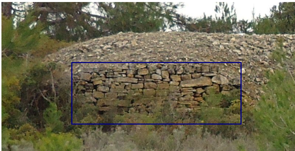
Рисунок 3. Каменная стена, различимая на стороне выше уровня дороги
